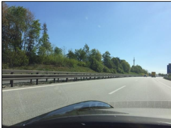
Abb. 2 Blick von Südwesten in Fahrtrichtung Passau
