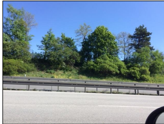
Abb. 4 Blick auf Böschung mit Gehölzpflanzungen (Blick von Süden)
